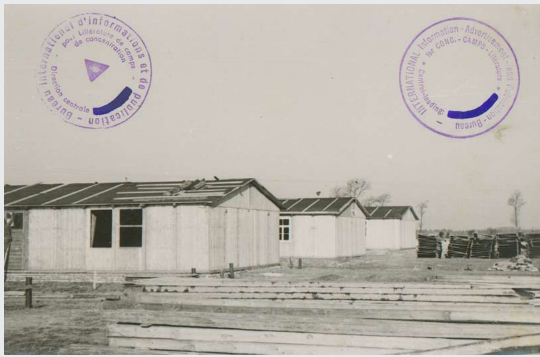
Errichtung der Häftlingsunterkünfte im KZ Neuengamme, 1940. Foto: unbekannt, 11,2 cm × 17 cm. (ANg, Bestand Masset, 1981-217)
