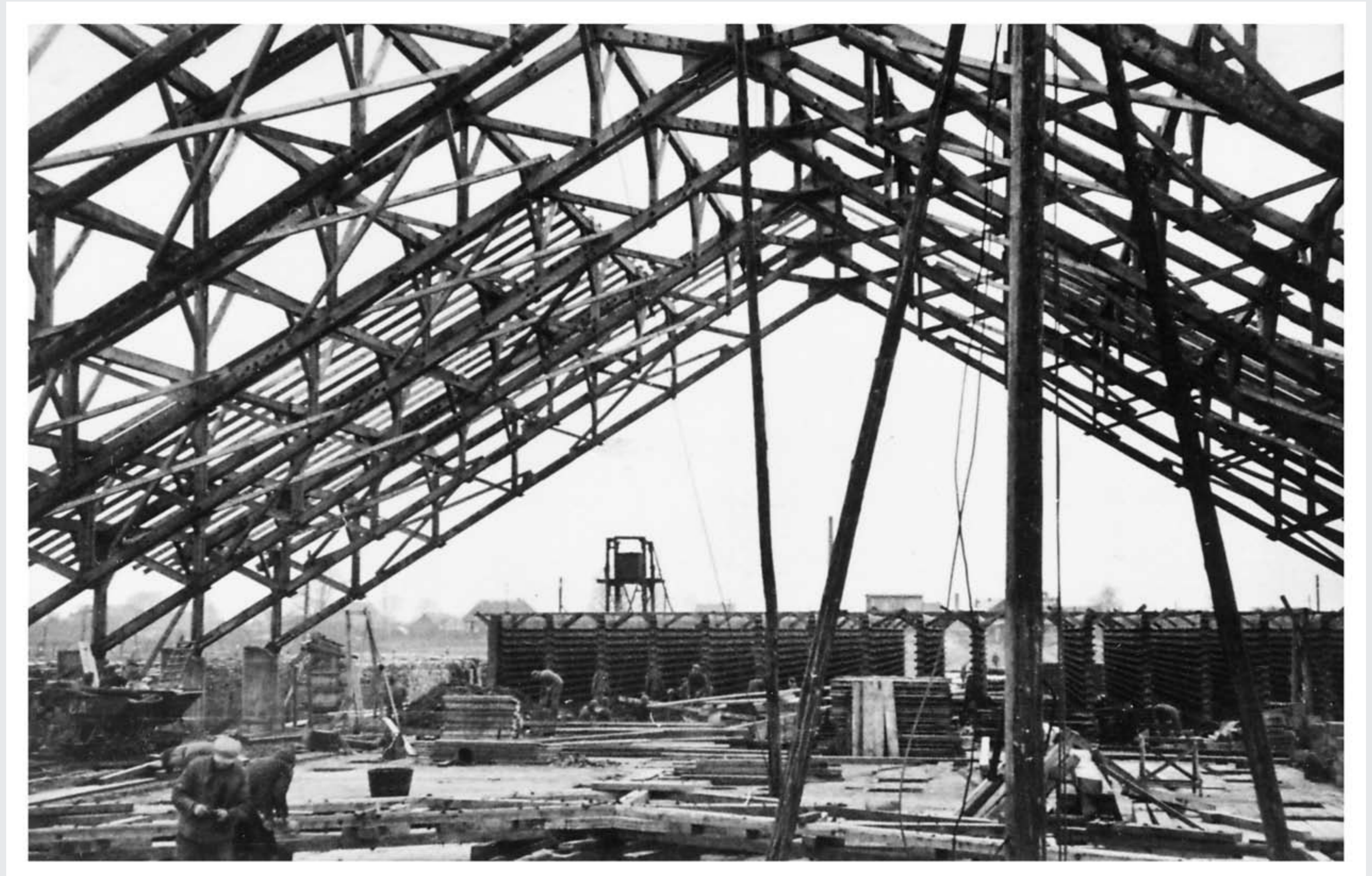
Errichtung der Dachkonstruktion des neuen Klinkerwerks, Anfang 1941. Foto: unbekannt, 8,7 cm × 13,5 cm. (SAPMO-BArch, Bild Y 1-3249)
