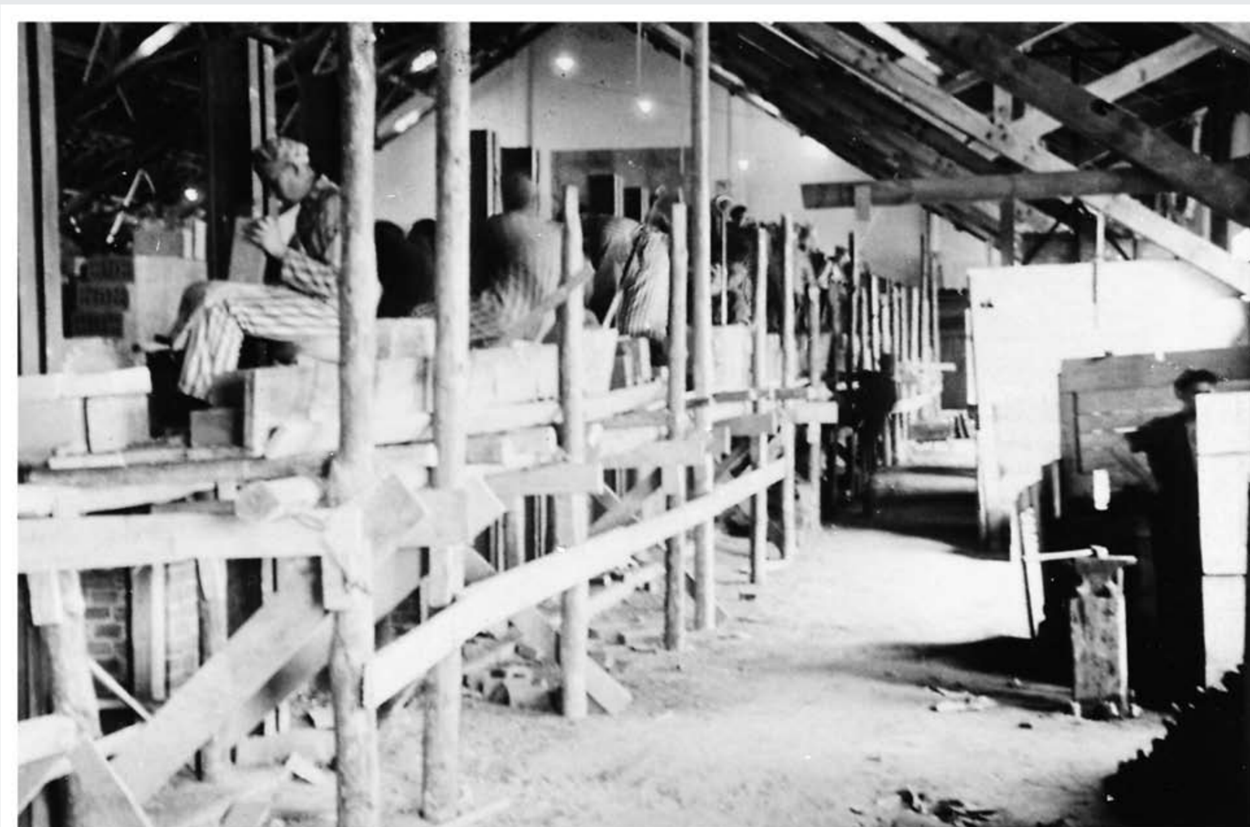
Im neuen Klinkerwerk mussten Häftlinge 1941 die Zickzacköfen I und II errichten, in denen Klinkersteine gebrannt wurden. Für die Maurerarbeiten wurden Häftlinge eigens ausgebildet. Originalbeschriftung des SS-Archivs: »Ofenhaus I.« Foto: unbekannt, 9,8 cm x 6,4 cm. (SAPMO-BArch, V 1-3230)
