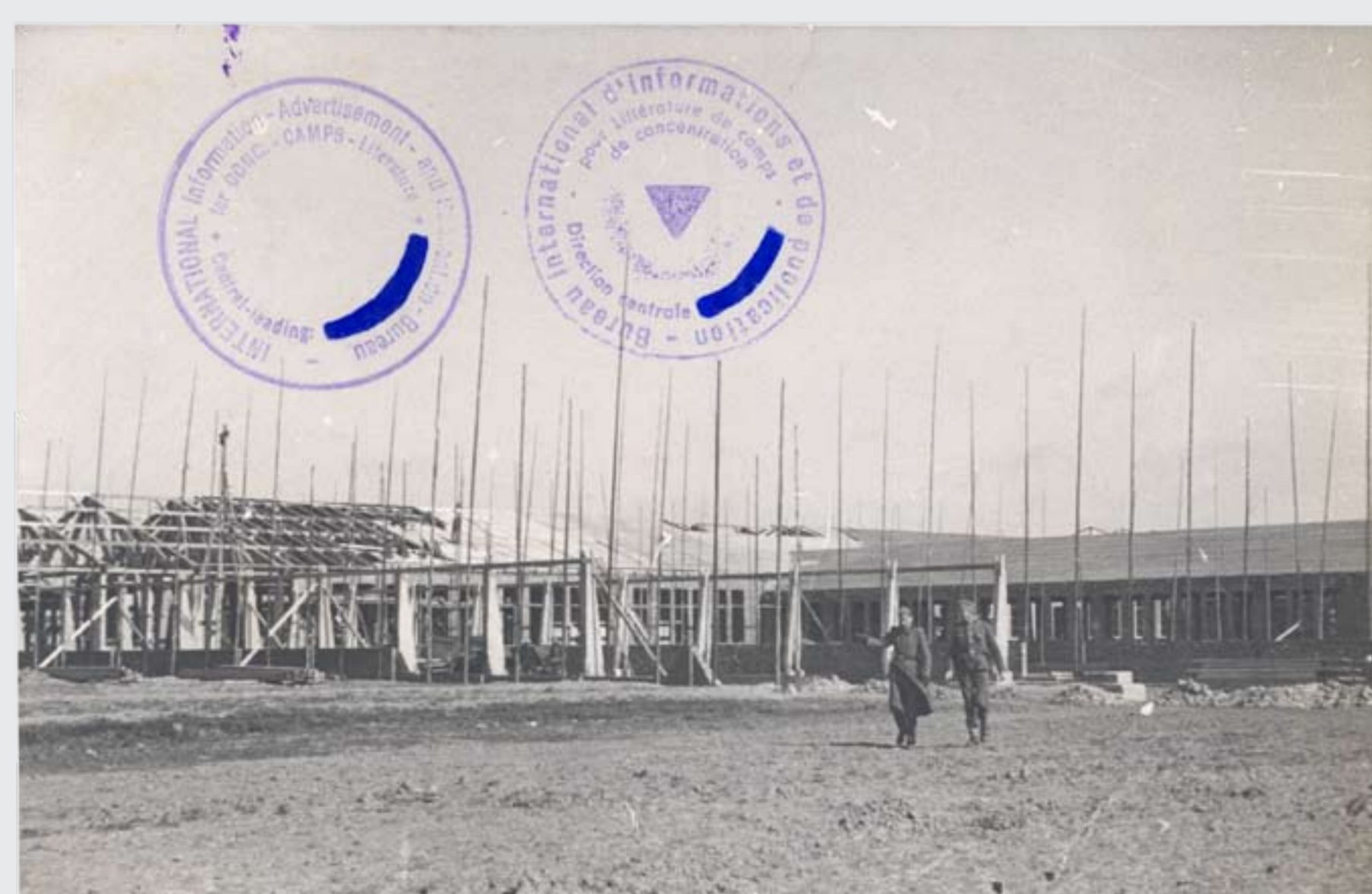
Errichtung der Produktionshalle der »Metallwerke Neuengamme GmbH«, 1943. Foto: vermutlich Josef Schmitt, 10,6 cm × 16,7 cm. (ANG, Bestand Masset, 1981-315)
