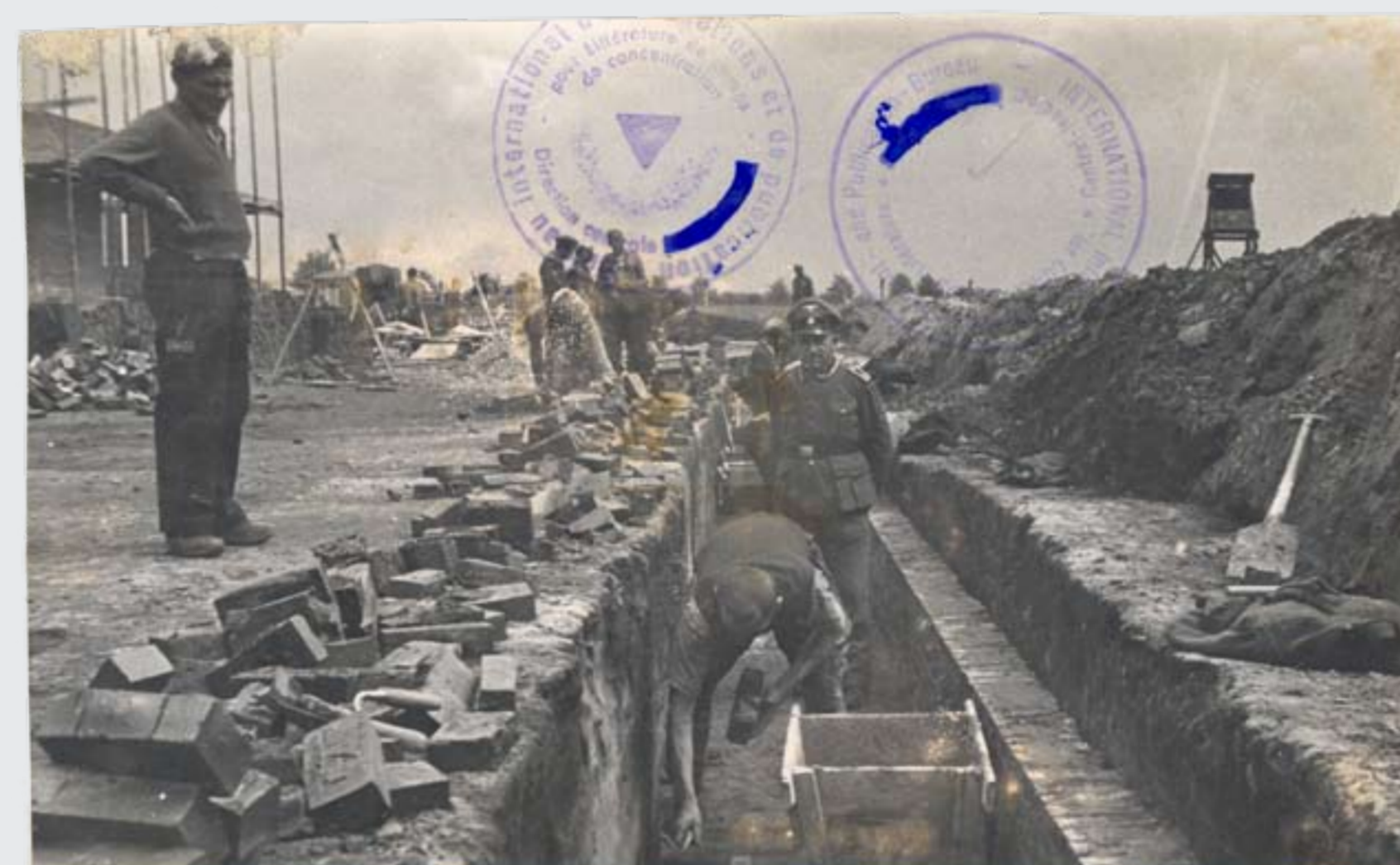
Häftlinge bei Fundamentierungsarbeiten für die »Metallwerke Neuengamme GmbH«, 1943. Links ein Kapo (Vorarbeiter), in der Bildmitte ein SS-Oberscharführer, vermutlich der Kommandoführer, der für das Foto in die Baugrube gestiegen ist. Die SS-Leute hatten sich eigentlich auf Distanz zu den Häftlingen zu halten, handwerkliche Anleitungen waren Aufgabe der Funktionshäftlinge, wie hier des Kapos. Foto: vermutlich Josef Schmitt, 10,2 cm × 16,8 cm. (ANG, Bestand Masset, 1981-243)
