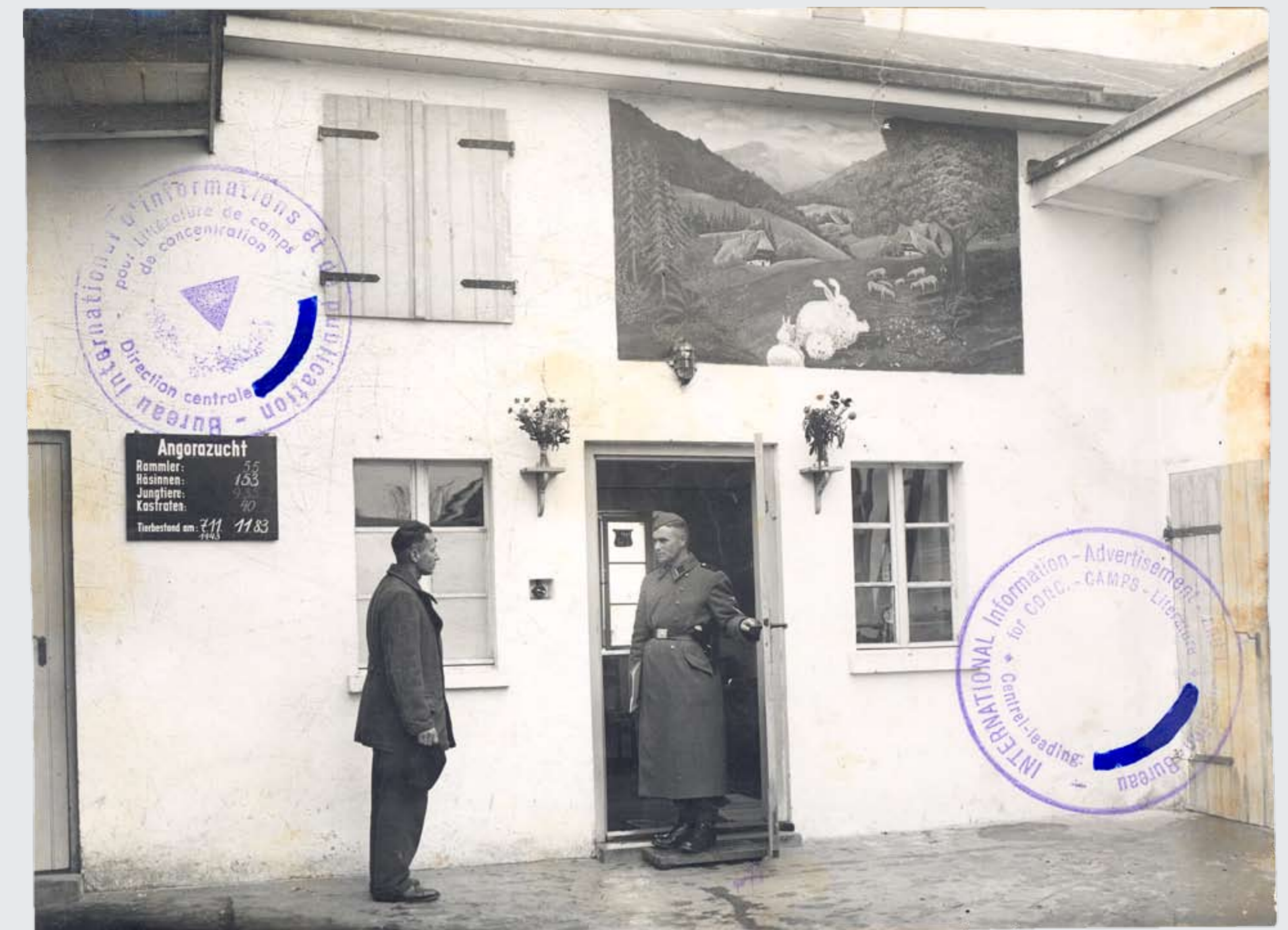
Ansicht des Kopfgebäudes der Angorakaninchenzucht im KZ Neuengamme vom Innenhof zwischen den Seitenflügeln der Anlage. Im Obergeschoss des Kopfgebäudes befand sich ein Heulager für die Tiere, im Erdgeschoss das Büro des Kommandoführers. Der Häftling Willi Johe hatte im Auftrag der SS über die Tür eine Schwarzwaldlandschaft mit Kaninchen auf die Wand gemalt. Der SS-Sturmmann in der Tür ist unbekannt, links handelt es sich vermutlich um den Kapo (Vorarbeiter) Heinrich Gerlach. Auf dem Bestandsschild links ist das Datum »7.11.1943« vermerkt. Dies ist wahrscheinlich auch der Tag der Aufnahme. Foto: vermutlich Josef Schmitt, 12,2 cm x 16,4 cm. (ANg, Bestand Masset, 1981-316)
