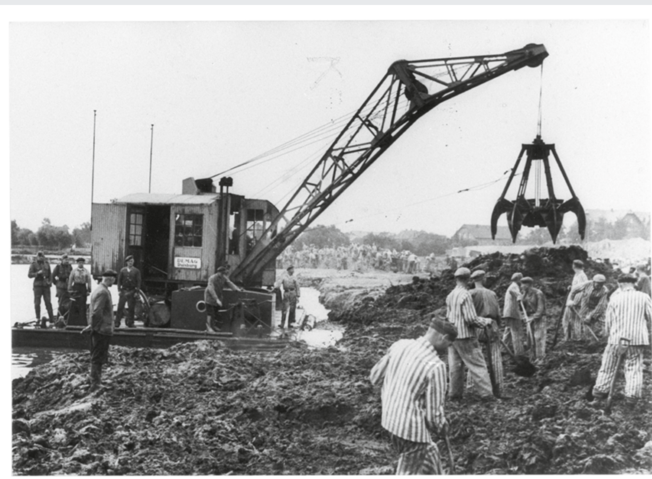
Einsatz eines Schwimmbaggers bei Arbeiten im »Kommando Elbe«. Die ausgehobene Erde wird von den Häftlingen an Land verteilt. Aufnahme 1941/42. Foto: vermutlich Albert Ernst, 13 cm x 18 cm. (NIOD, 244 F-177-38)
