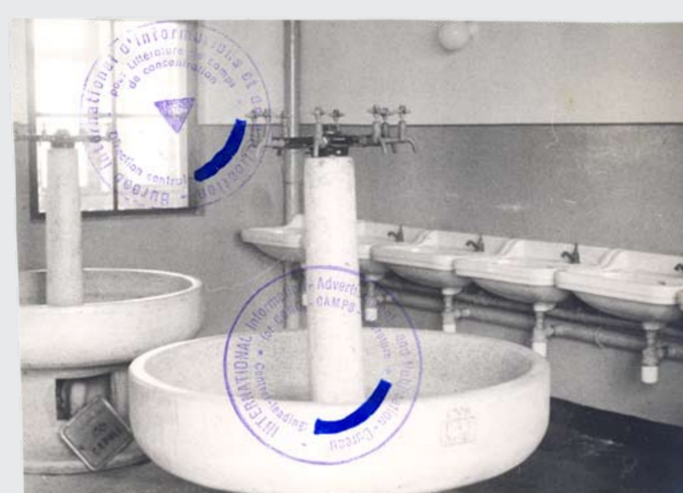
Waschraum in einem der beiden 1944 fertiggestellten Klinkergebäude als Häftlingsunterkünfte. Aufnahme von 1945. Foto: vermutlich Josef Schmitt, 9,1 cm × 12,7 cm. (ANG, Bestand Masset, 1981-312)
