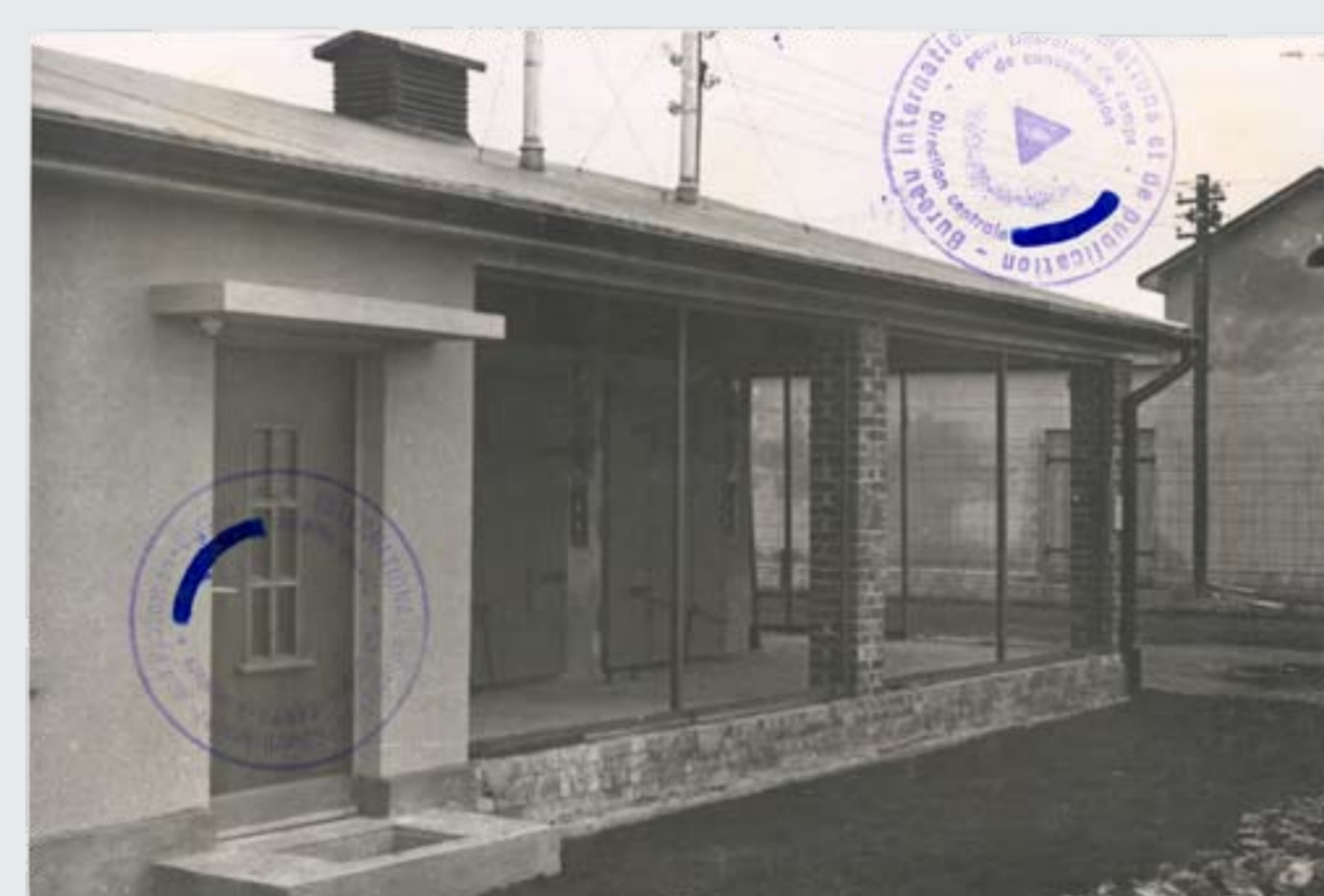
Die Entlausungsanlage, die 1942 am Rand des Häftlingslagers errichtet wurde. Grund für die Einrichtung der Anlage war eine vor allem durch Läuse übertragene Flecktyphusepidemie, der viele Hundert Häftlinge zum Opfer gefallen waren. Aufnahme 1942/43. Foto: vermutlich Josef Schmitt, 11 cm × 16,8 cm. (ANG, Bestand Masset, 1981-271)
