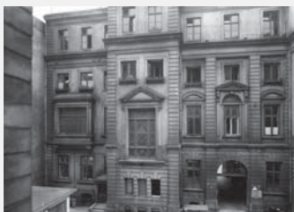
Die historische Rückfront des Görtz'schen Palais, Juli 1937. Die Rückfront wurde nach der Zerstörung des Gebäudes 1943 nicht wieder hergestellt. Foto: Hügelmann. (DA)
