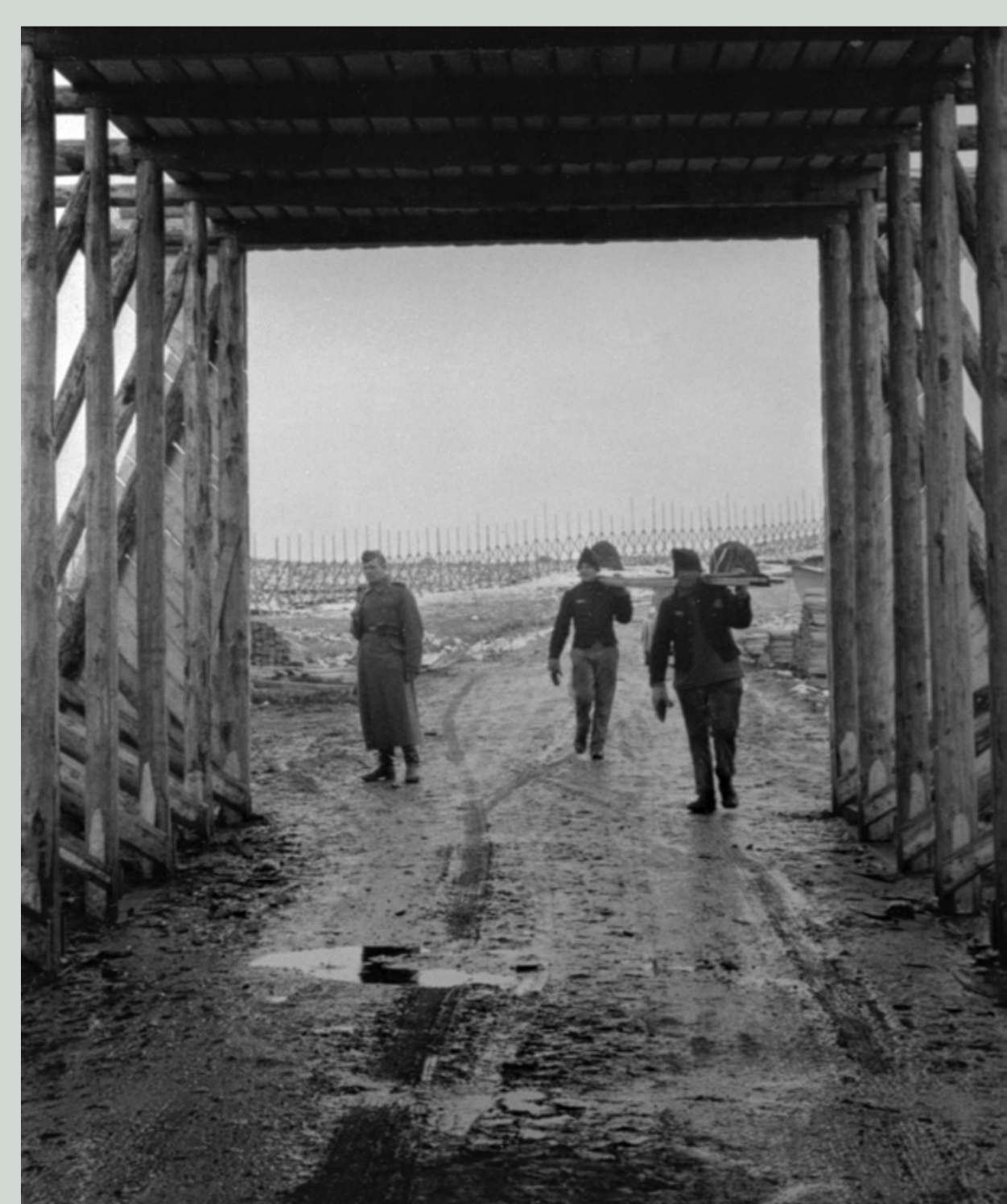
Bauarbeiten unter Bewachung im Lager Badderen/Nordnorwegen, Aufnahme der Propagandakompanie 681, 1943.
