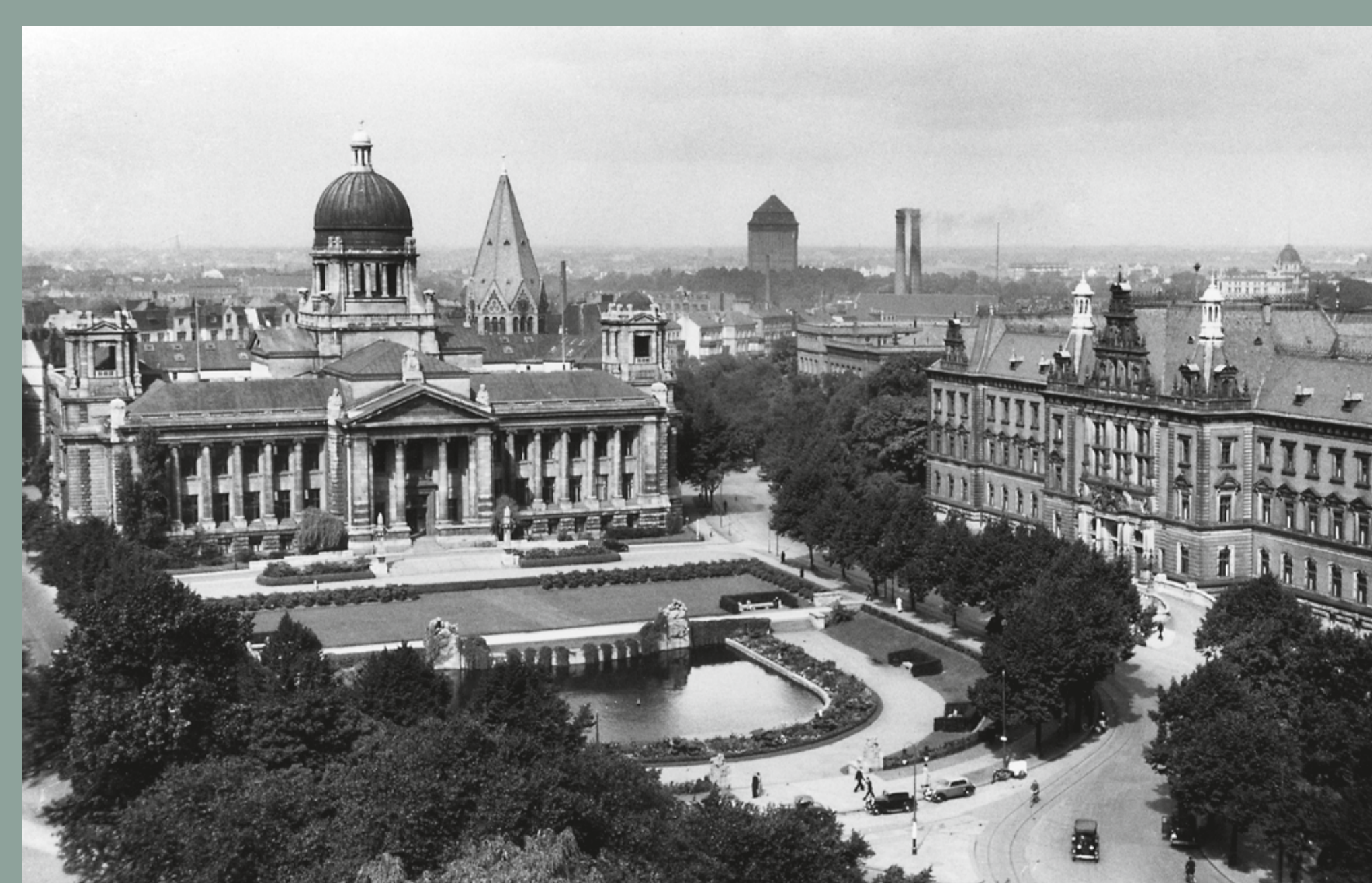
Gebäude des Hanseatischen Oberlandesgerichts (links) am Sievekingplatz in Hamburg, 1920er-Jahre.
