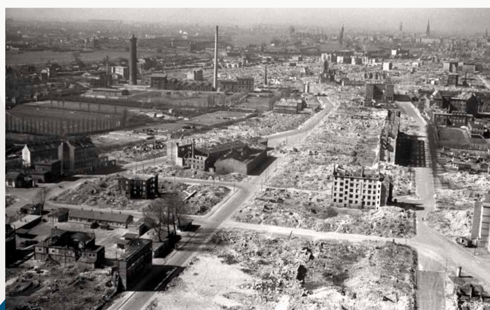
Der zerstörte Stadtteil Rothenburgsort, 1948. Links oben im Bild der Wasserturm am Billhorner Deich, im Hintergrund die kaum beschädigten Brücken über die Norderelbe.
