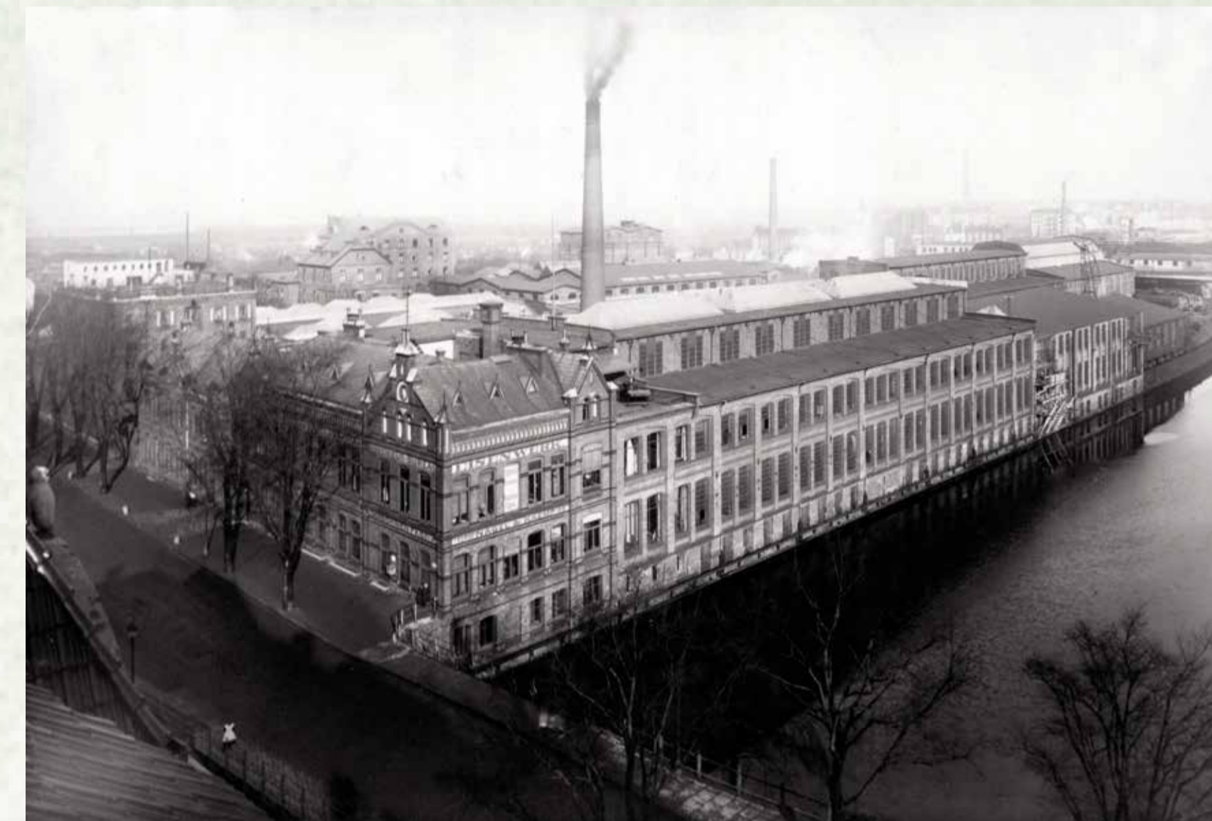
Die Maschinenfabrik Nagel & Kaemp am Osterbekkanal, 1910. Im Vordergrund die Barmbeker Straße.
