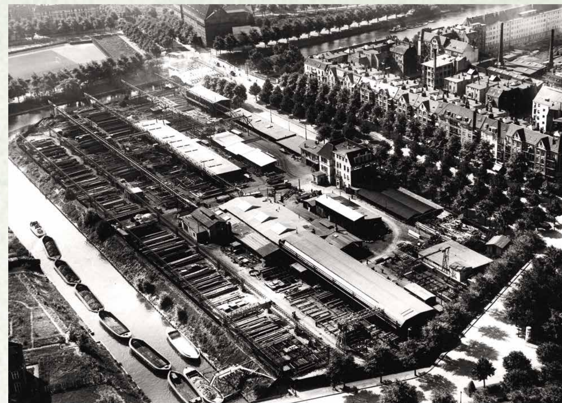
Das Werksgelände der Carl Spaeter GmbH, ca. 1930. Links verläuft der Barmbeker Stichkanal, oben der Osterbekkanal. Die Saarlandstraße führt vom rechten Bildrand nach links oben. Heute ist das Areal mit Wohnungen des Projekts „Autofreies Wohnen“ bebaut.
