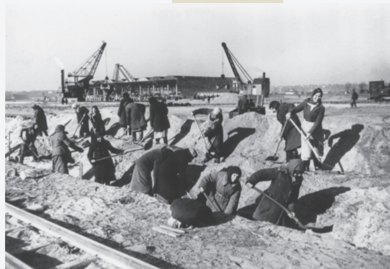
Sowjetische Zwangsarbeiterinnen bei Erdarbeiten am Diestelkai in Hamburg-Finkenwerder, 1943
