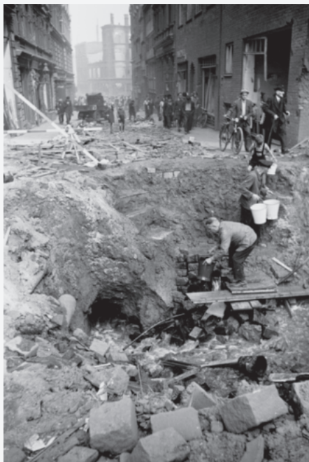
Anwohner nutzen eine geborstene Wasserleitung in der Neustädter Straße in Hamburg-Neustadt als Trinkwasserquelle, vermutlich August 1943.
