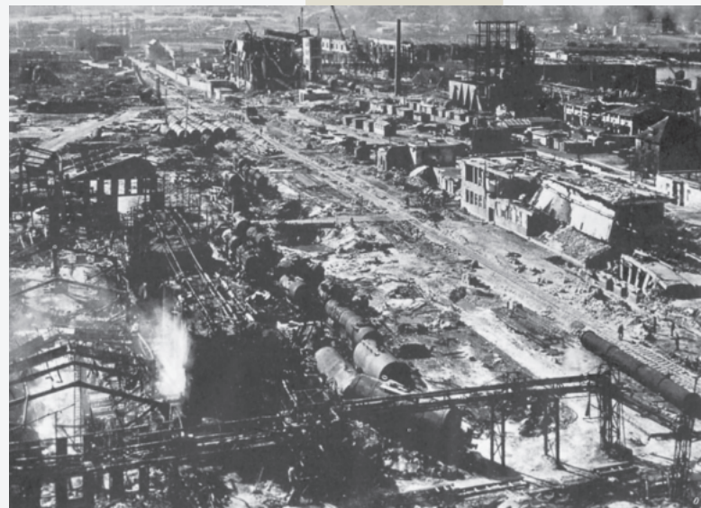
Die bei US-amerikanischen Luftangriffen zerstörte Shell-Raffinerie in Hamburg-Harburg, vermutlich 1945
