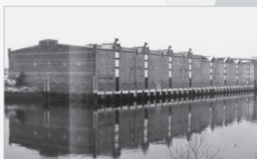
Lagerhauskomplex am Dessauer Ufer, links Lagerhaus G, 1982
