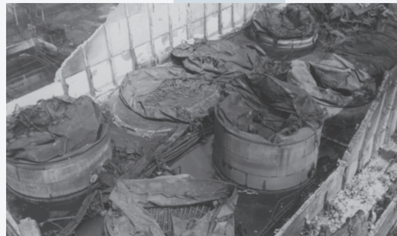
Beschädigtes Öltanklager der Rhenania-Ossag Mineralölwerke AG (Shell) in Hamburg-Harburg nach einem Bombenangriff am 20. Juni 1944 (Ausschnitt)
