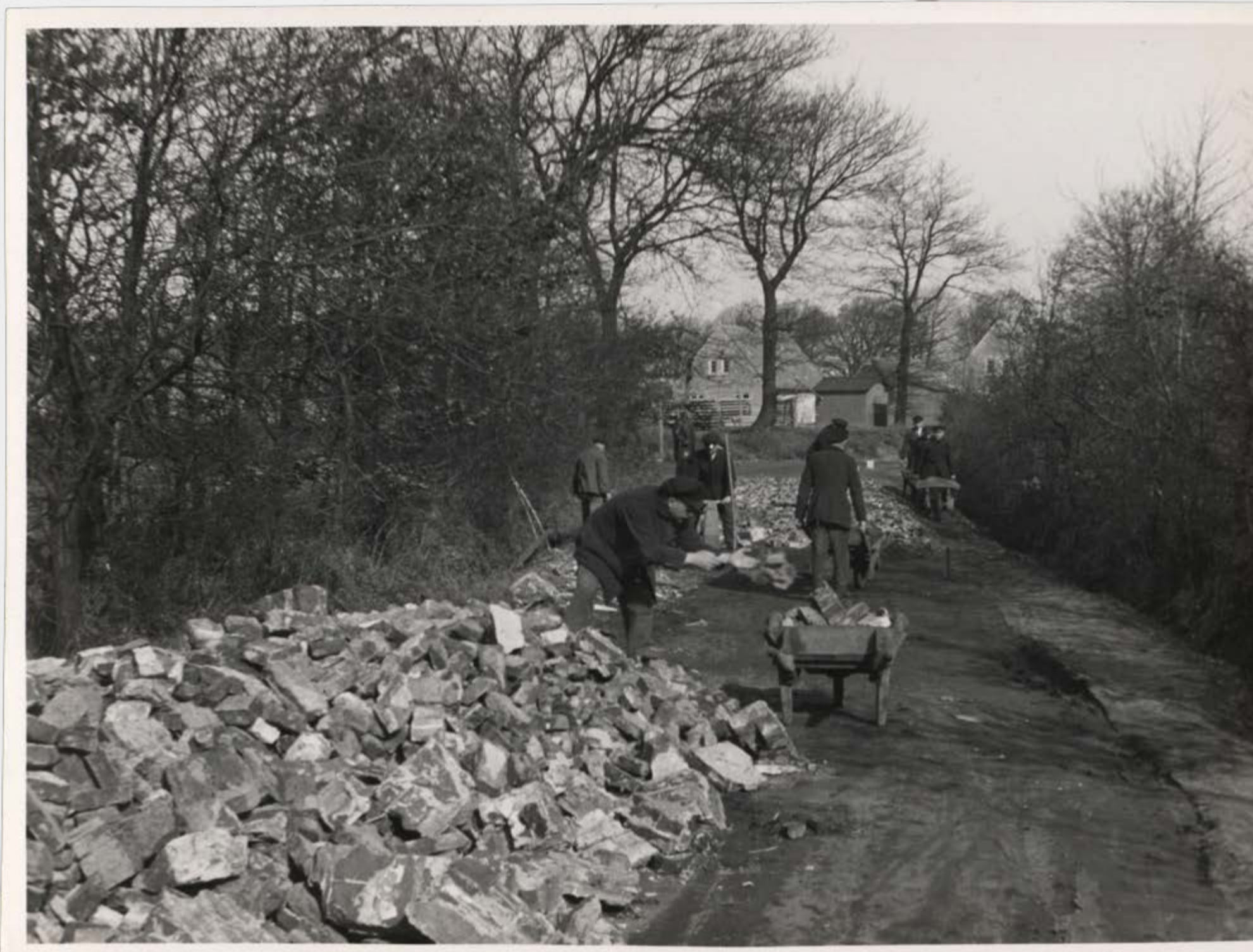
Pflasterung des Suckwegs in Hamburg-Langenhorn im Rahmen einer Arbeitszwangsmaßnahme , November 1937
