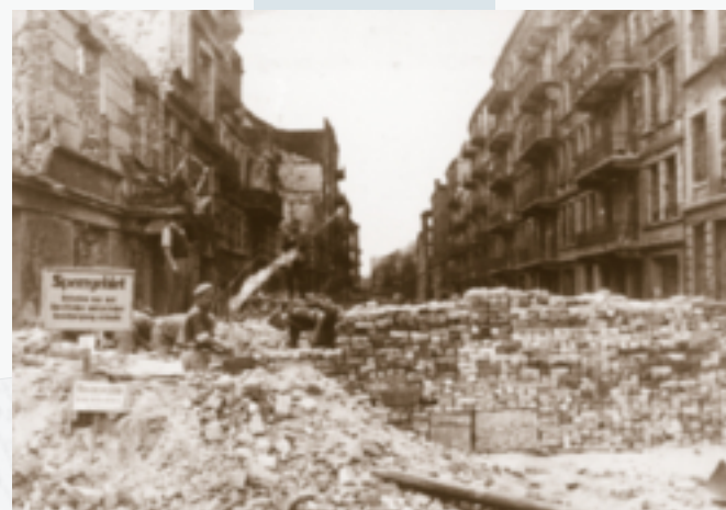
Häftlinge des KZ Neuengamme beim Errichten einer Sperrmauer im Stadtteil Hammerbrook, vermutlich im August 1943
