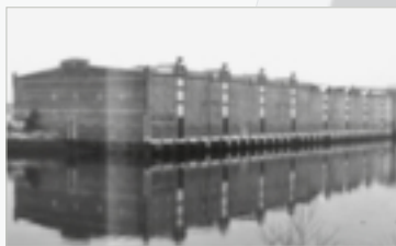
Lagerhauskomplex am Dessauer Ufer, links Lagerhaus G, 1982
