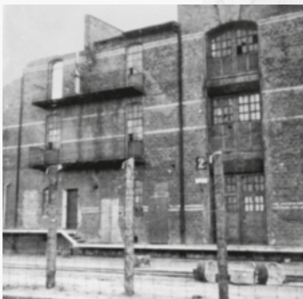
Lagerhaus G am Dessauer Ufer in Hamburg-Veddel (Teilansicht), nicht datiert. Der Hafenspeicher diente 1944/45 zunächst für weibliche, später für männliche Häftlinge als Außenlager des KZ Neuengamme.
