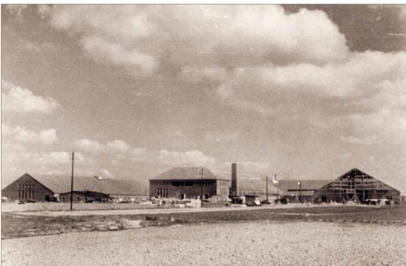
Der mittlere Flügel (Maschinenhaus und Kesselhaus) und der westliche Flügel des Klinkerwerks wurden Anfang 1942 errichtet.
