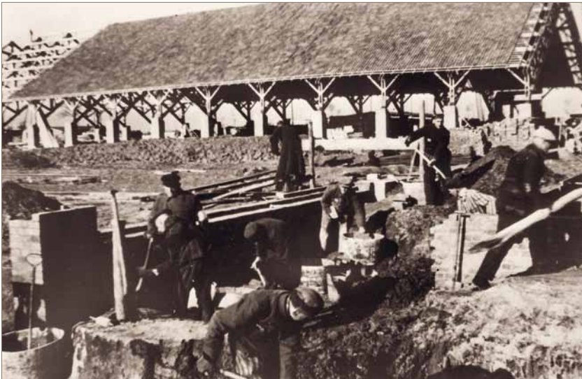
Der Westflügel des Klinkerwerks (im Hintergrund), vorne Kanalisationsarbeiten, 1941.
