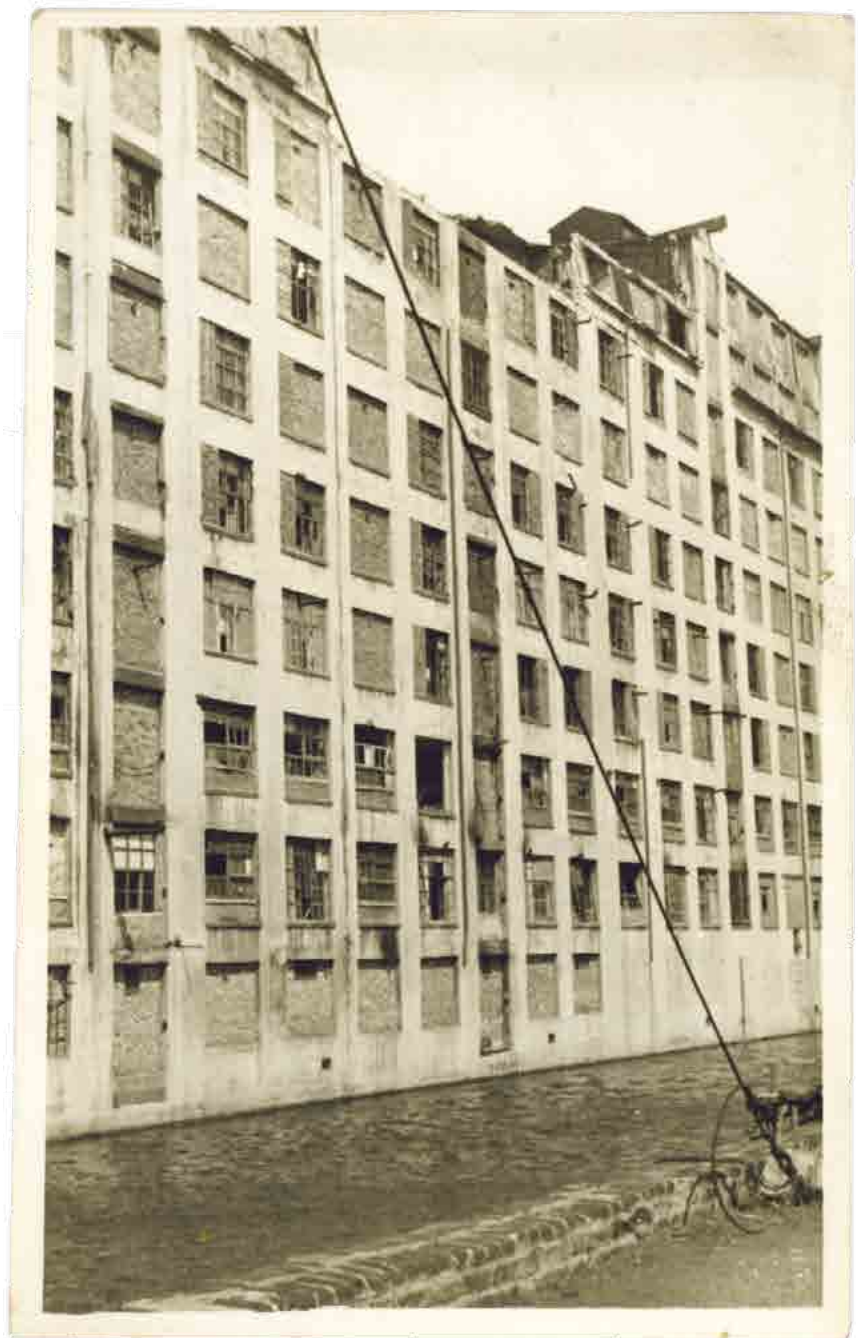
Das Hinterhaus Spaldingstraße 156/158, in dem die Häftlinge untergebracht waren, kurz nach Kriegsende.
