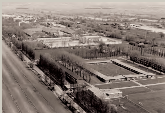
Luftaufnahme der beiden Justizvollzugsanstalten, 1993. Vorne die JVA XII (1948–1970 „Männergefängnis Neuengamme“, ab 1970 „Justizvollzugsanstalt Vierlande“, dahinter die JVA IX (1970–1990 „Jugendanstalt Vierlande“, dann „Justizvollzugsanstalt IX“). Im Hintergrund sind das Klinkerwerk und das Mahmal der KZ-Gedenkstätte zu erkennen.
