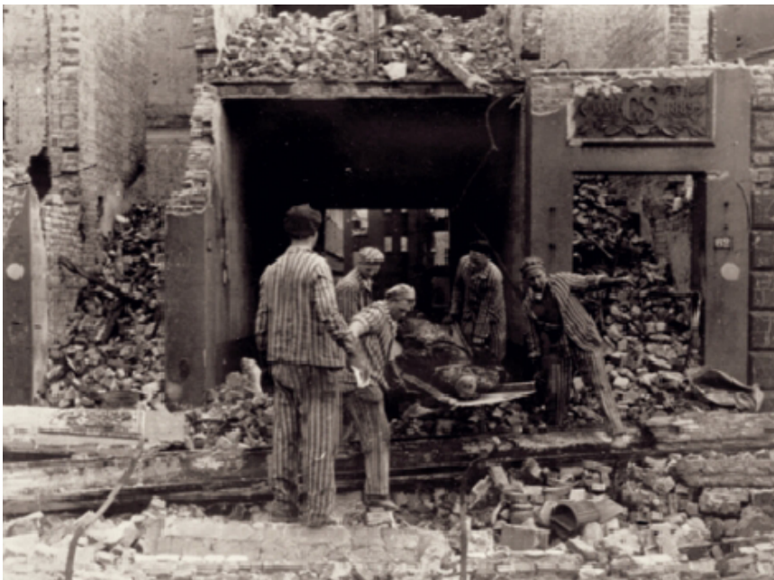
Détenus déblayant les décombres dans un quartier de Hambourg bombardé, Hammerbrook, 1943.
