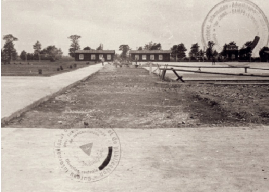
Travaux de bétonnage dans le camp des détenus, 1941; à droite, la place d'appel.
